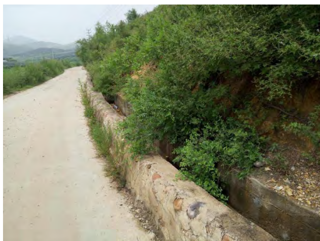
检修道路浆砌石排水沟
