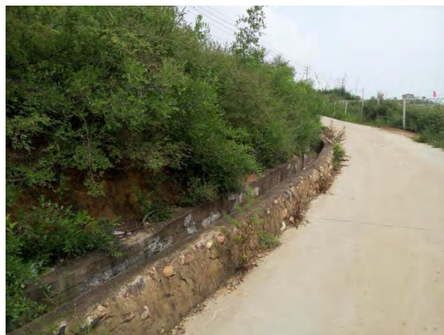
检修道路浆砌石排水沟
