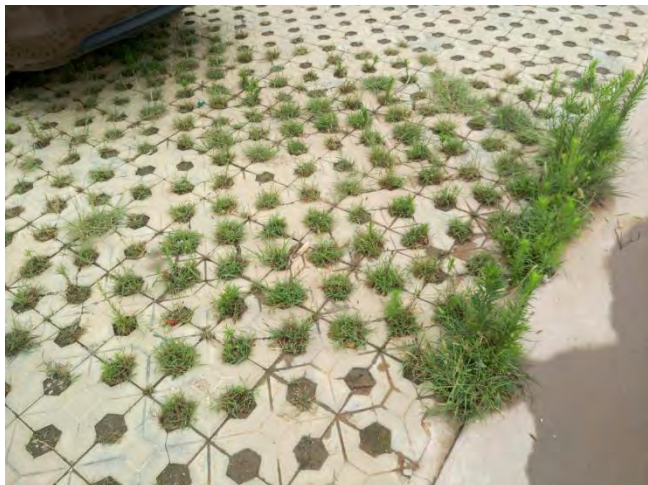
升压站内植草砖
