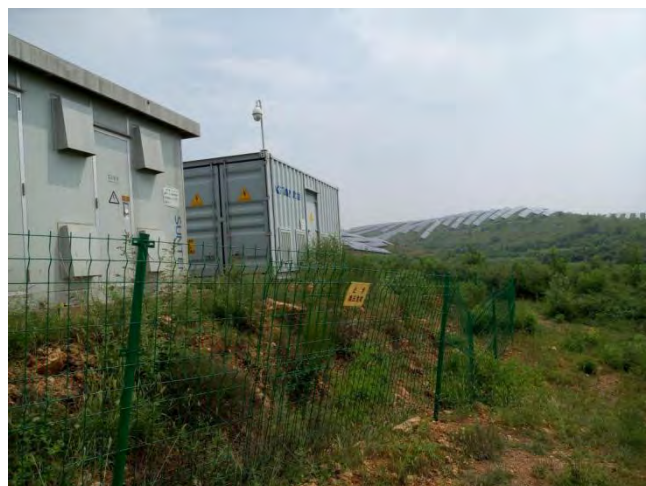
逆变器室植被恢复
