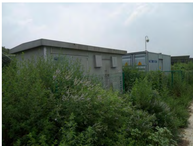
逆变器室植被恢复
