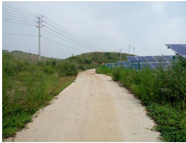
检修道路混凝土硬化路面
