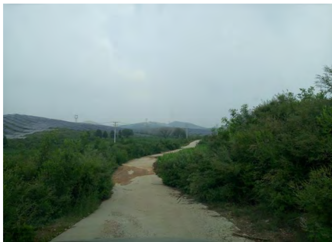
检修道路混凝土硬化路面
