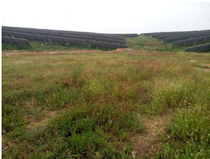
施工生产区植被恢复
