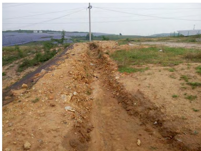
施工生产区土质排水沟
