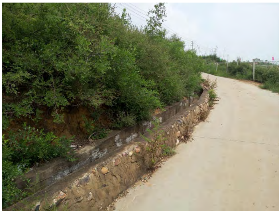
检修道路内侧浆砌石排水沟
