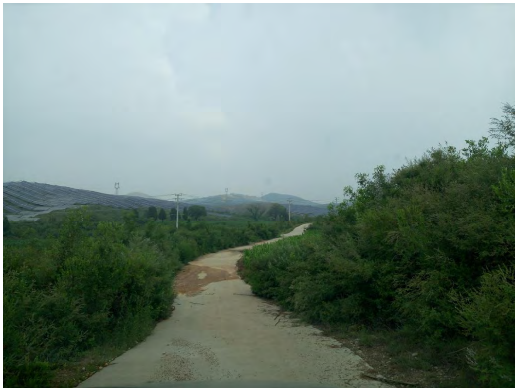
检修道路两侧植被恢复
