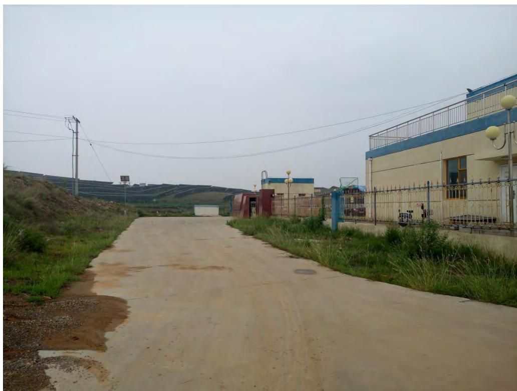
进站道路两侧植被恢复
