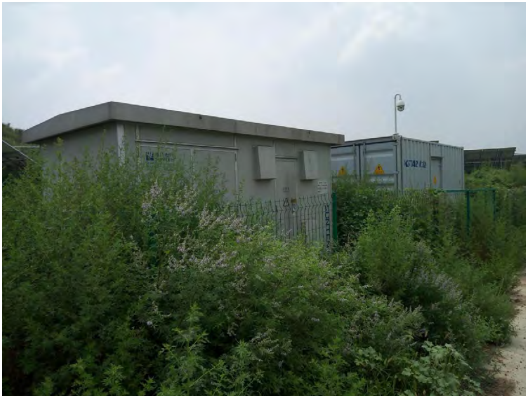
逆变器室植被恢复
