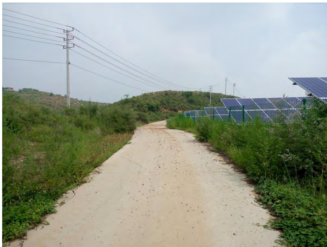
检修道路两侧植被恢复
