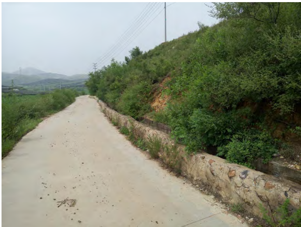
检修道路内侧浆砌石排水沟
