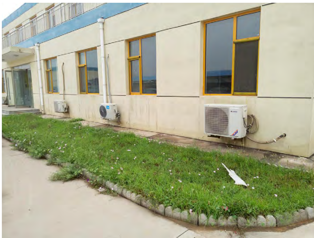
升压站内绿化
