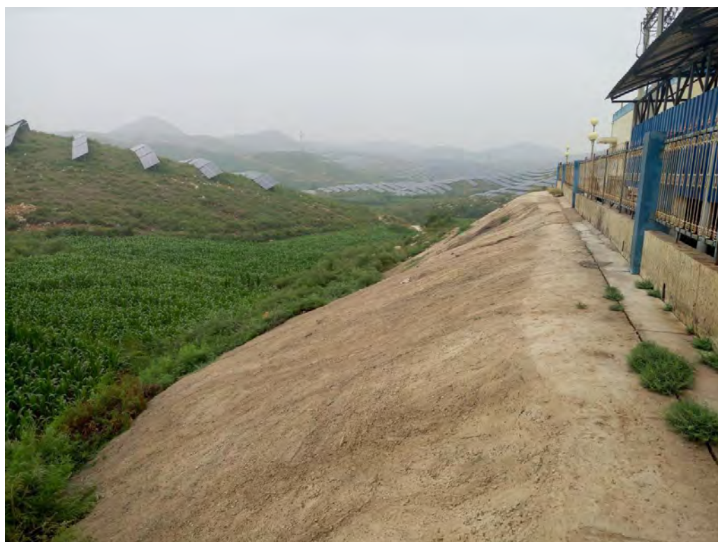
升压站外围喷锚护坡
