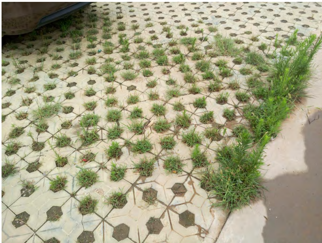
升压站内植草砖铺设
