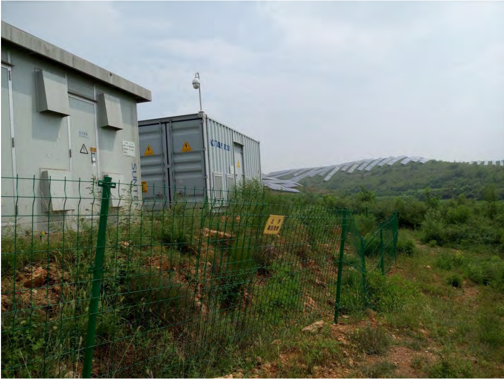
逆变器室植被恢复
