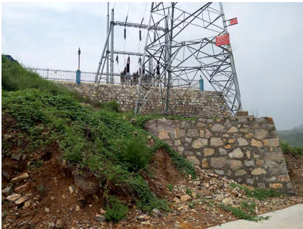
升压站外围浆砌石护坡
