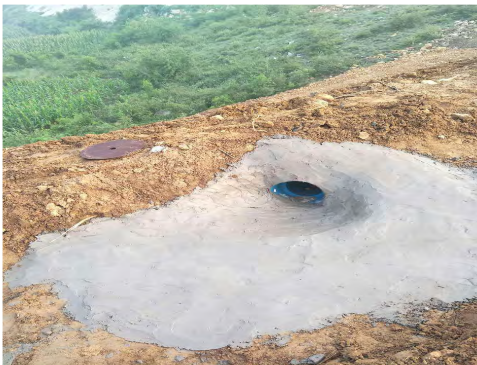
施工生产区埋设 PVC 排水管
