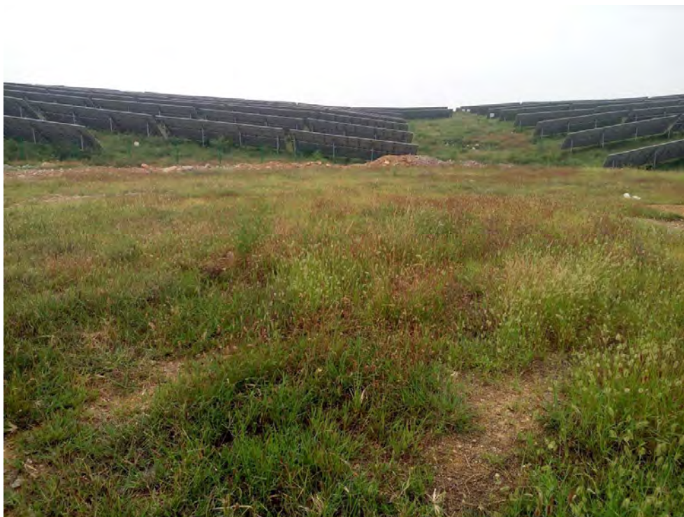
(2017 年 10 月) 施工生产区植被恢复
