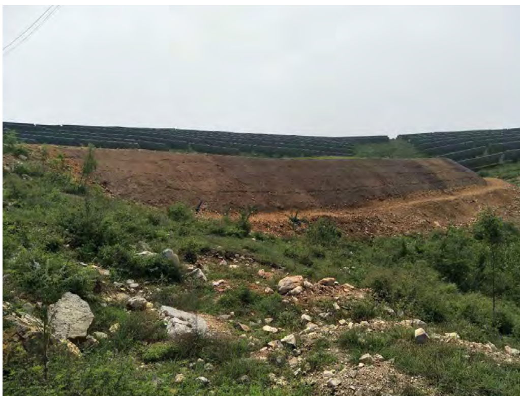
(2017 年 8 月) 施工生产区边坡种草绿化
