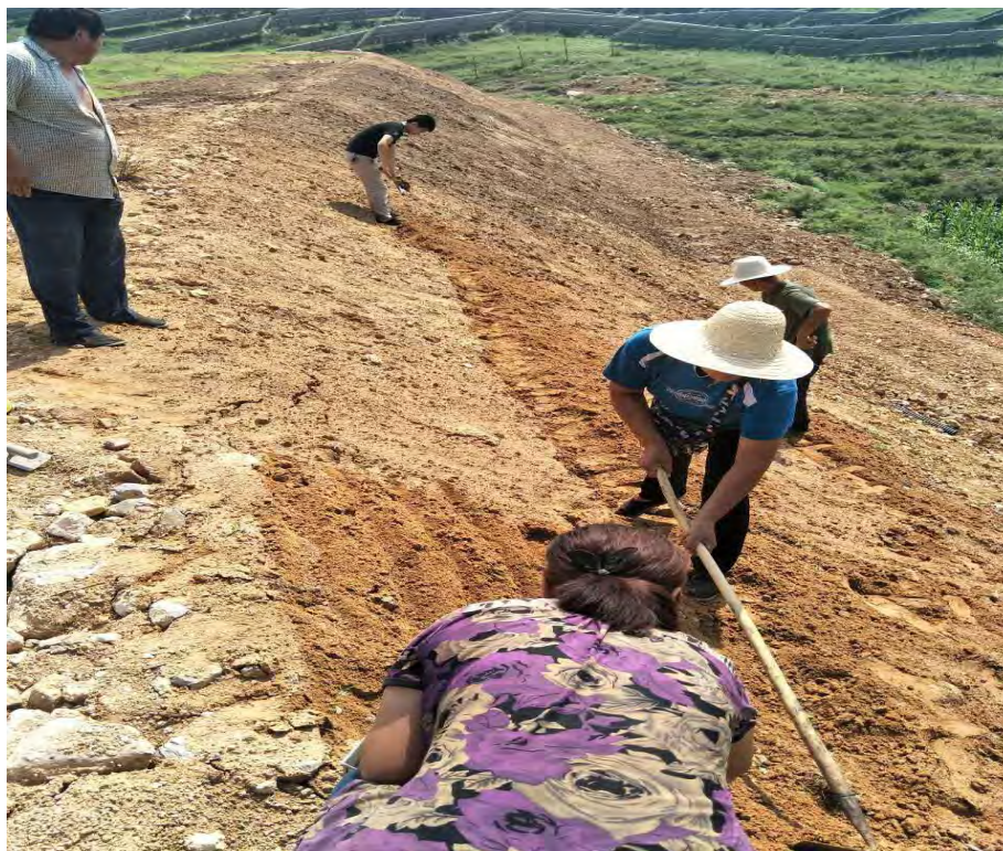
(2017 年 8 月) 施工生产区边坡种草绿化
