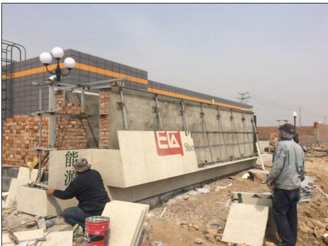
开关站门口施工
