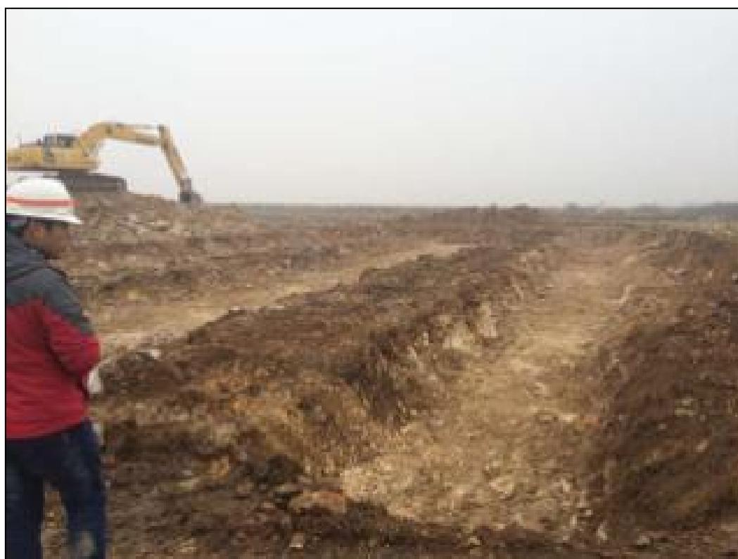
开关站基础开槽
