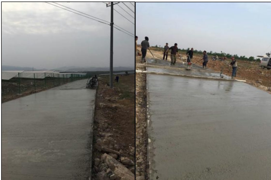
进场道路硬化
