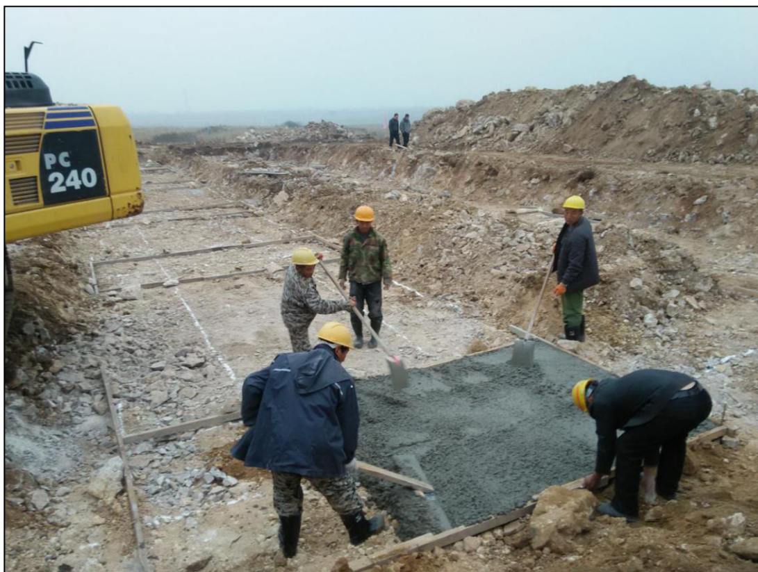
开关站基础垫层浇筑
