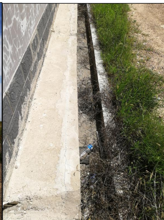
升压站外排水沟
