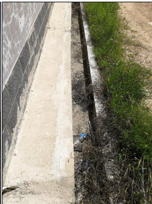
升压站外排水沟
