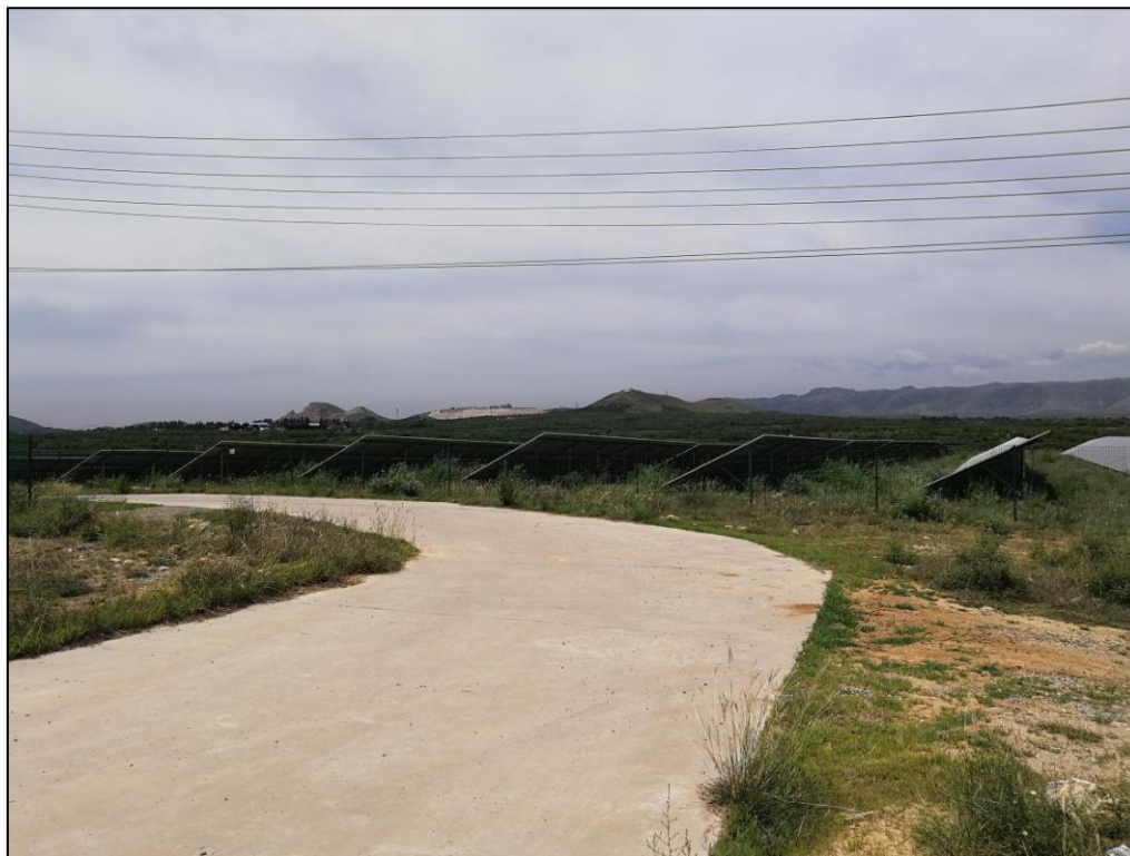
升压站附近植被恢复
