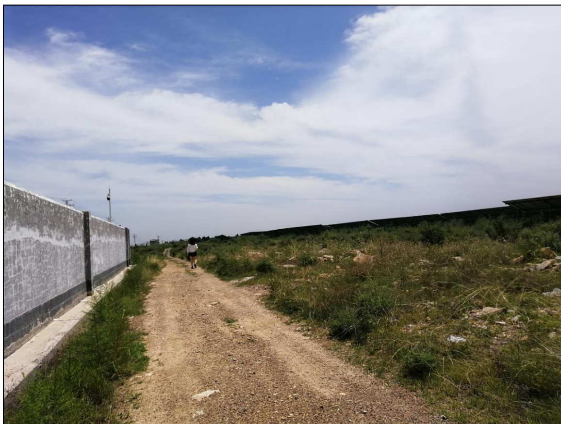
检修道路内侧排水沟
