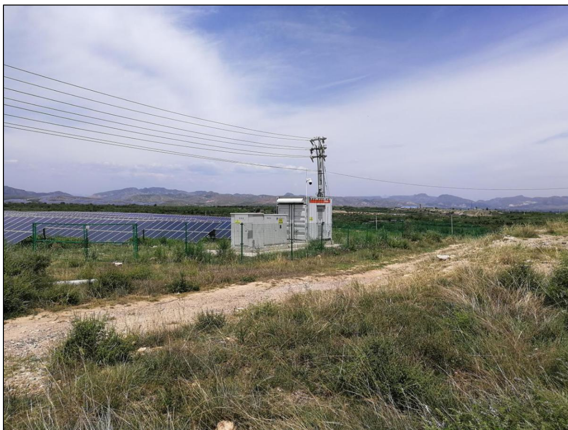
升压站附近植被恢复
