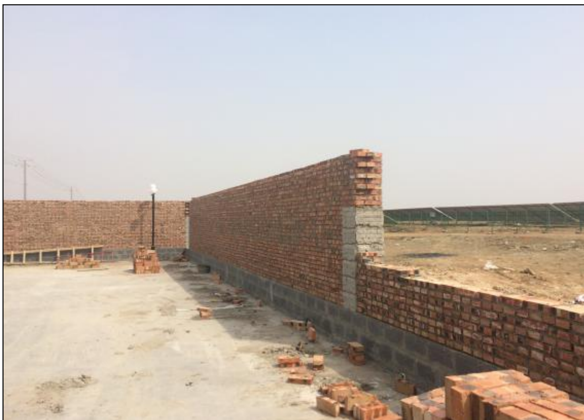
开关站围墙砌筑
