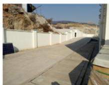
开关站外陡坡段水泥砂浆护坡
