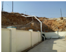
开关站外陡坡段水泥砂浆护坡
