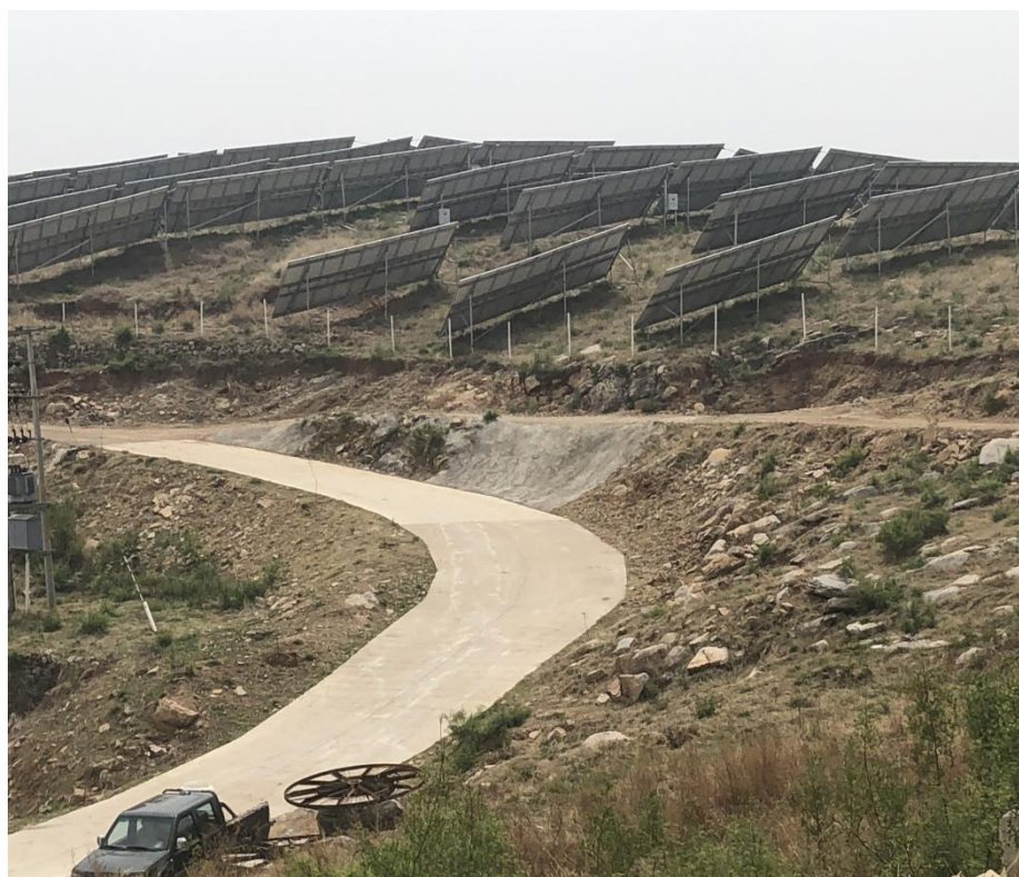
进站道路平整硬化
