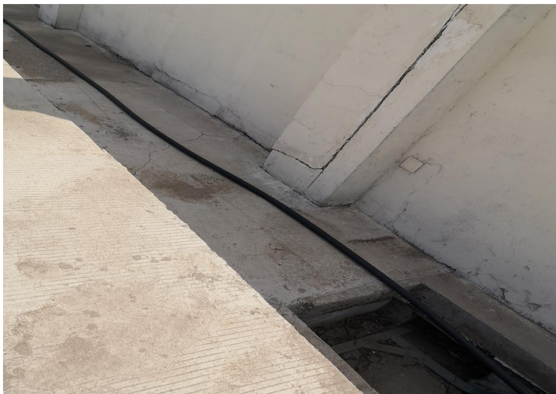
开关站混凝土排水沟
