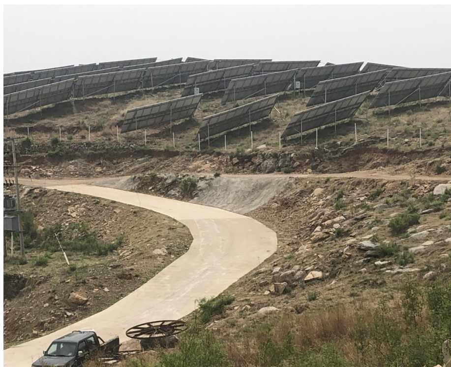
进站道路平整硬
