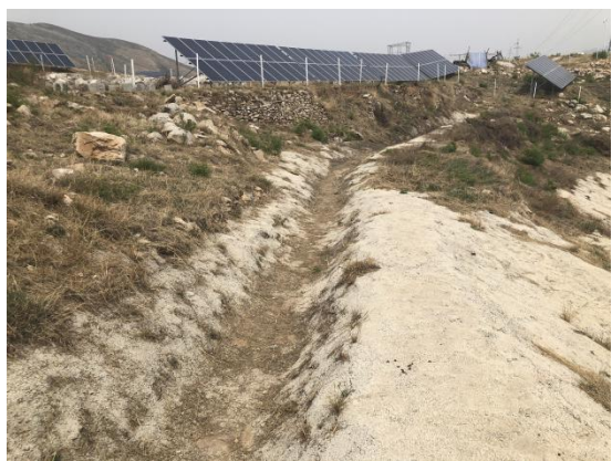
开关站外混凝土排水沟
