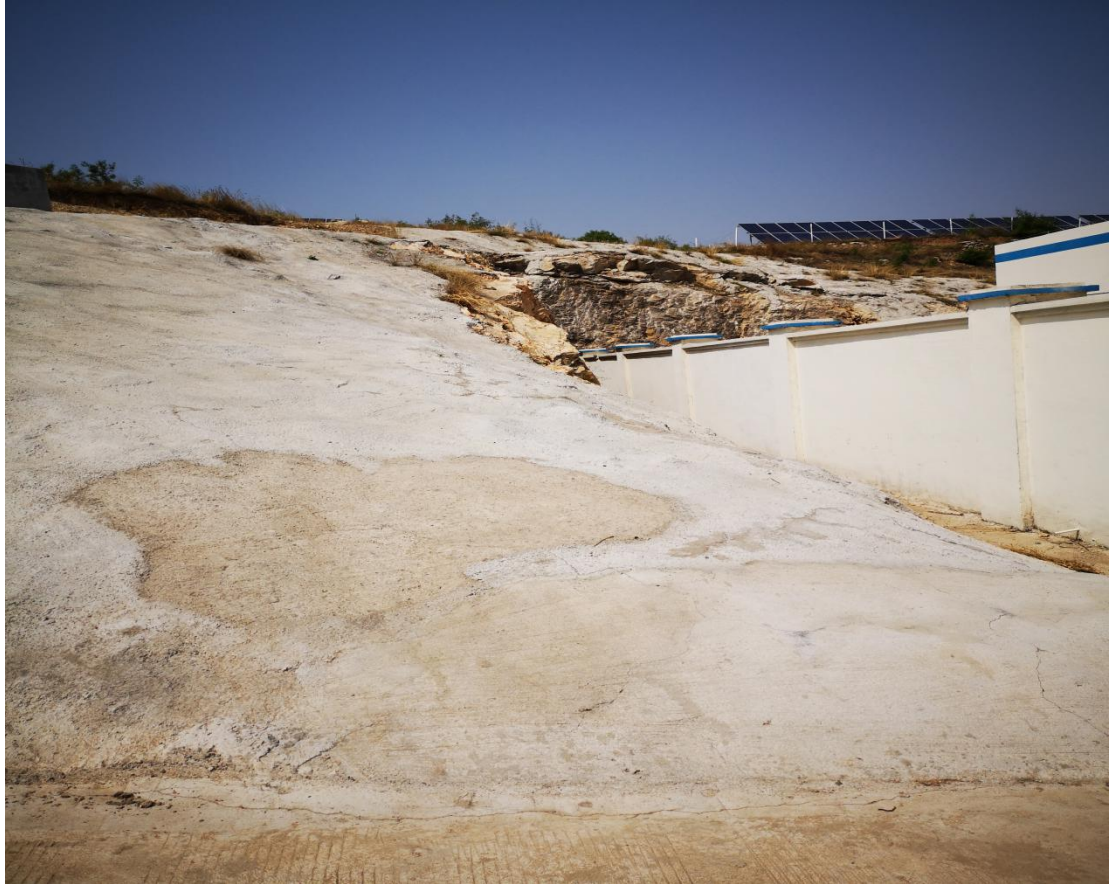
混凝土护坡
