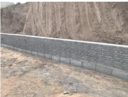
检修道路护坡
