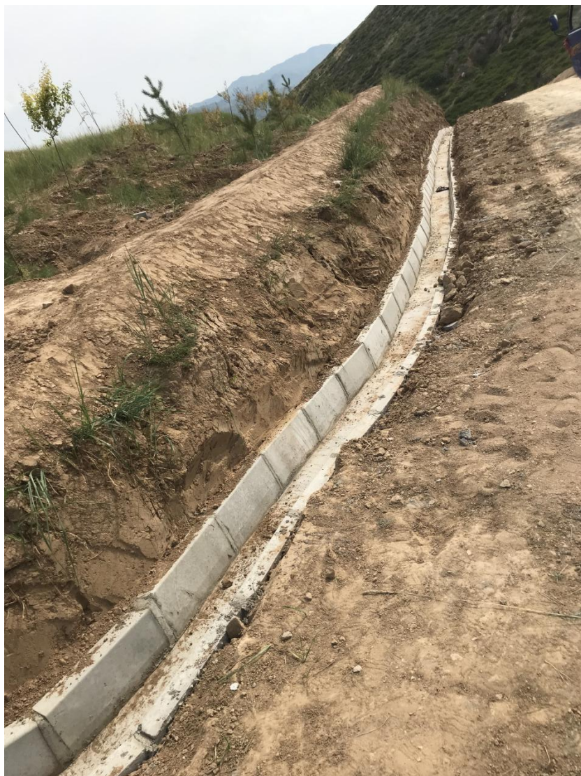
检修道路排水沟
