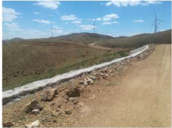
边坡治理工程 2018.06
