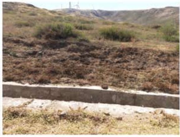
浆砌石排水沟 2019.09
