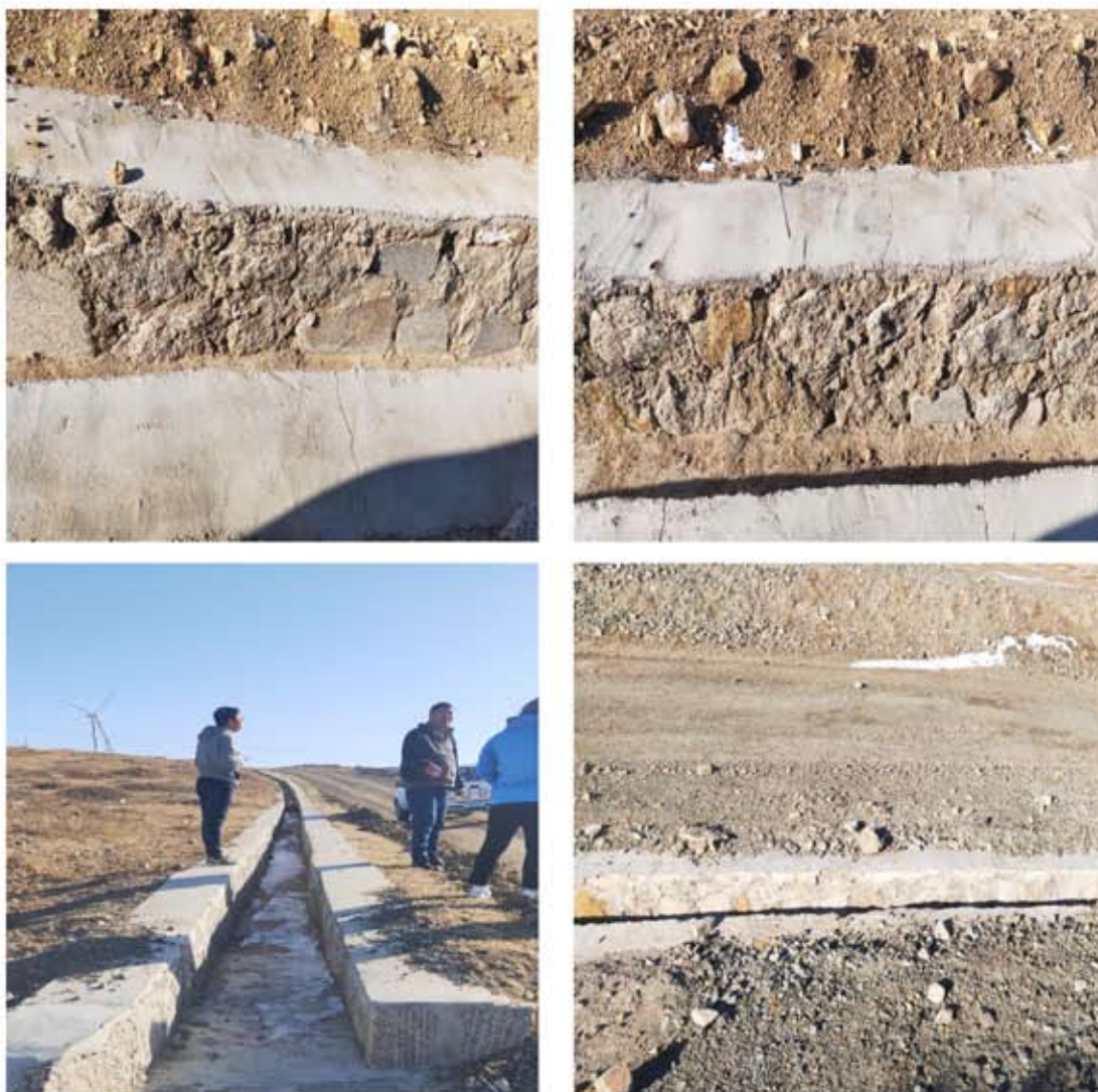
浆砌石排水沟
